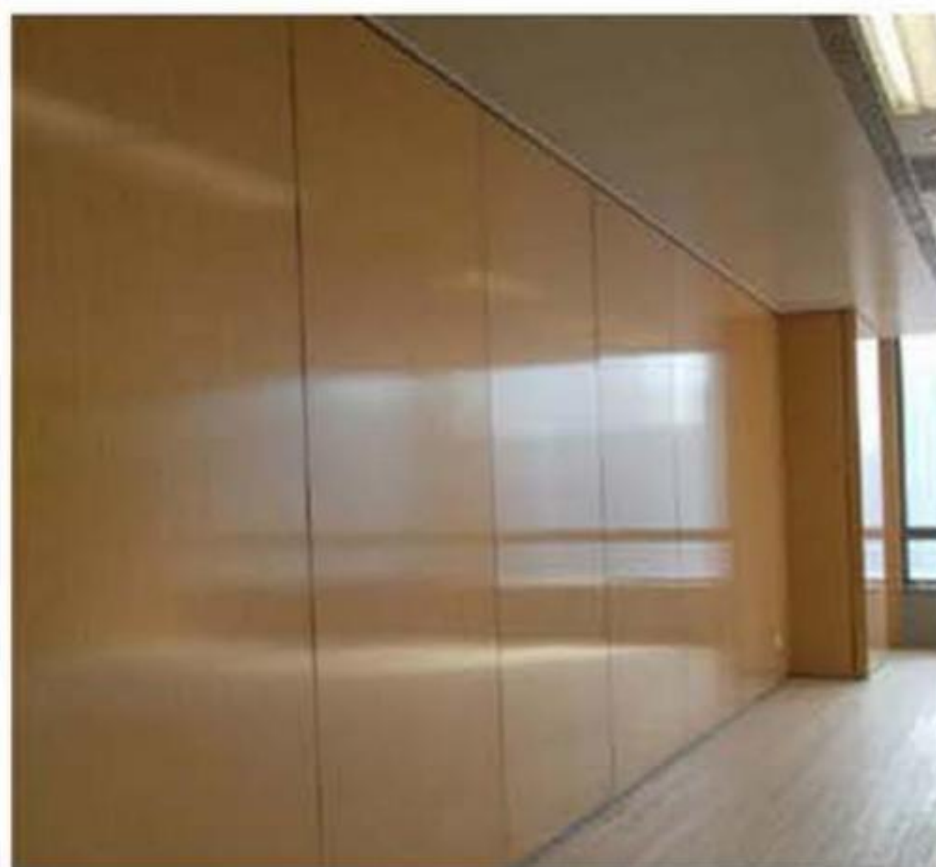
单侧挂墙板全钢隔墙系统
