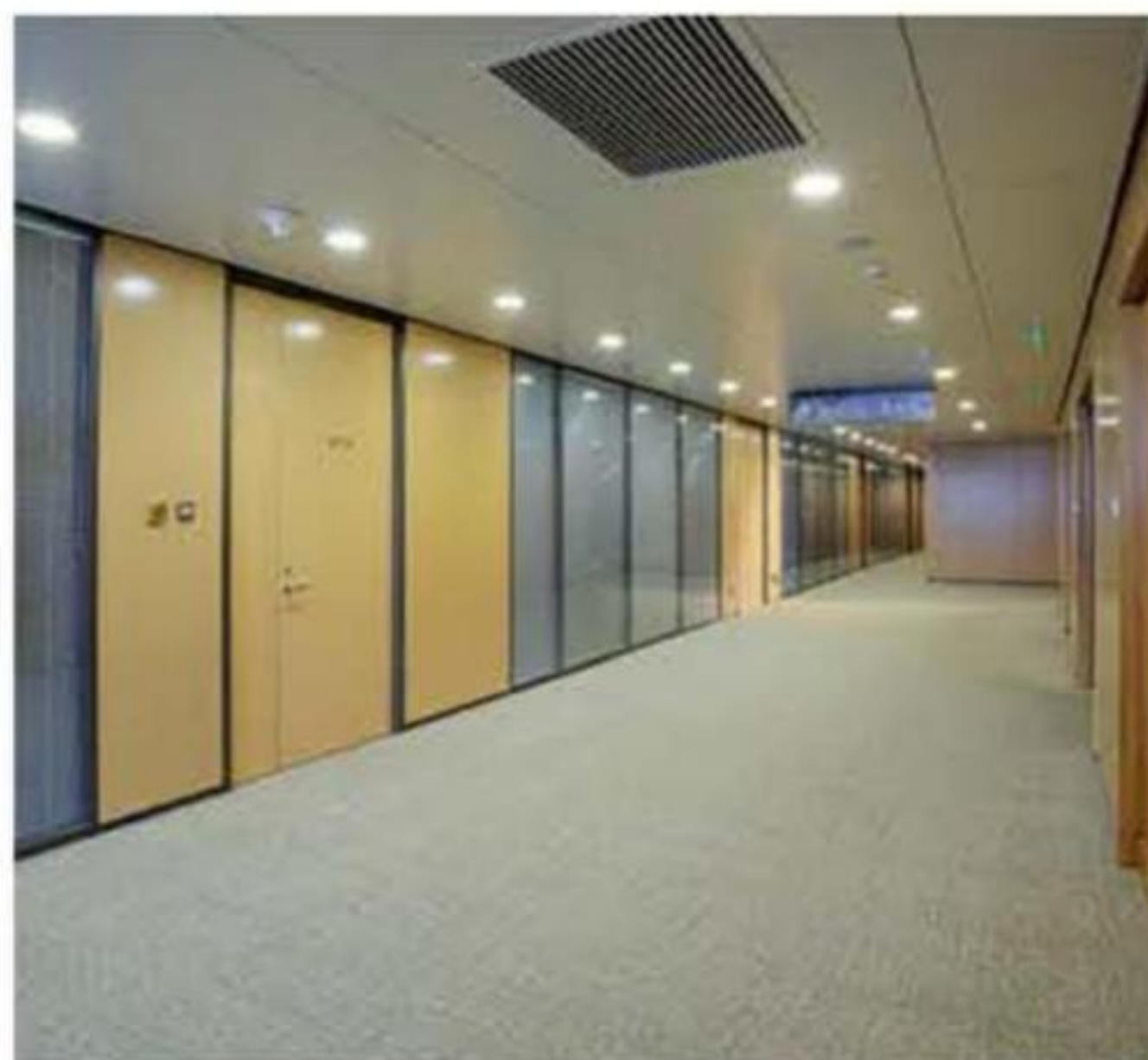
双层玻璃和双饰面板竖向组合全钢隔墙系统
